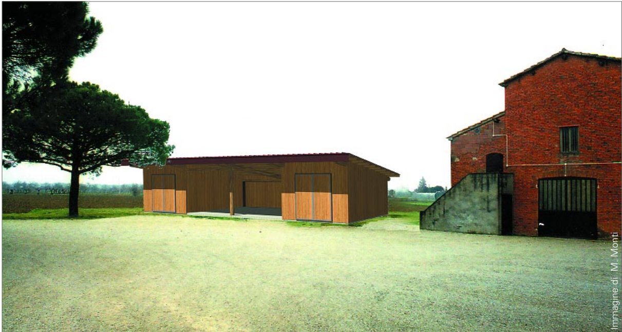
24. Ambientazione dell'edificio: doppio box centrale aperto per rimessa macchine e attrezzi agricoli; box laterali chiusi per uso rimessa macchine, deposito materiali vari e sementi
