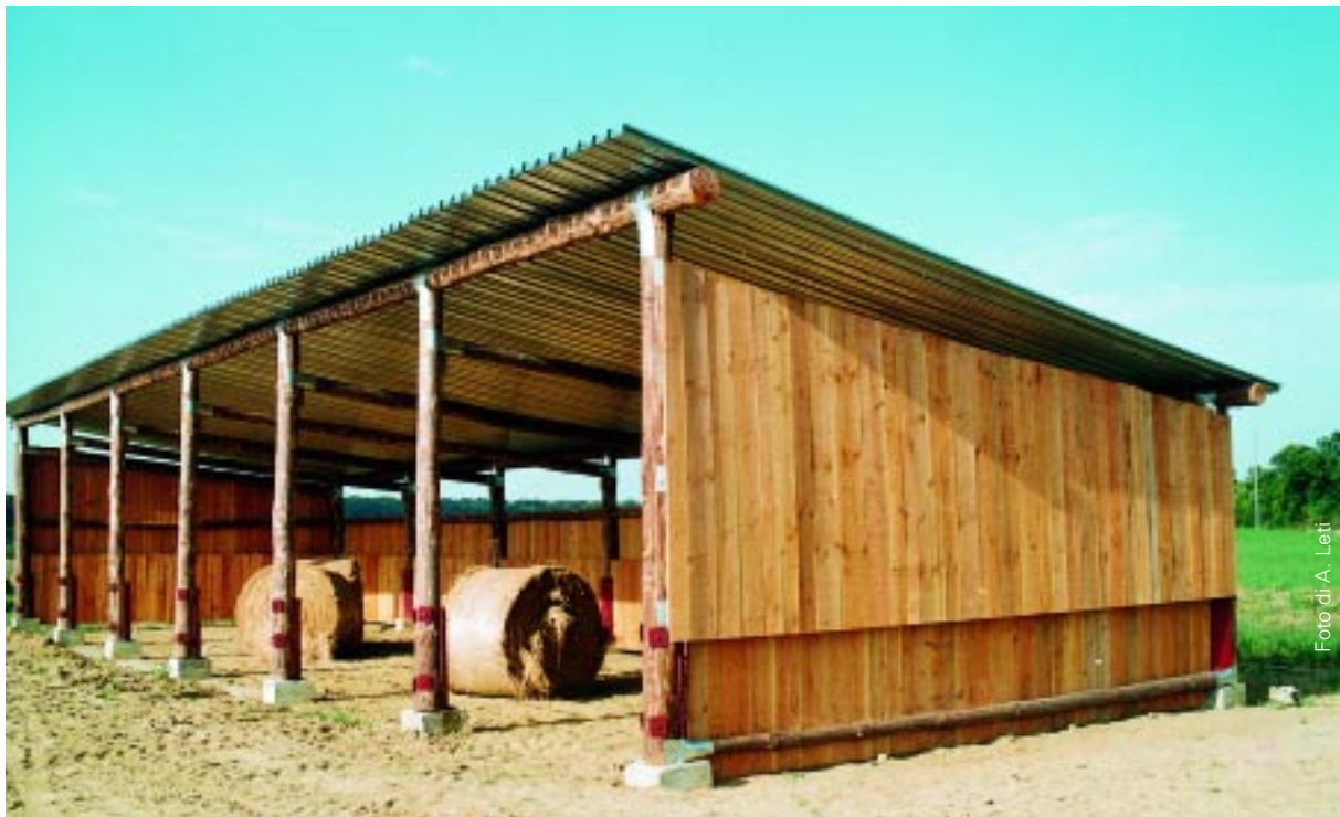
21. Zona di riposo. In evidenza la tamponatura in tavole e la copertura in lamiera zincata autoportante (anno 2000)
