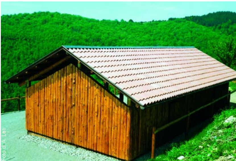
12. Visione panoramica del ricovero. La tamponatura esterna è realizzata con sciaveri di douglasia scortecciati, refilati e attestati, di spessore variabile da 4 a 6 cm
