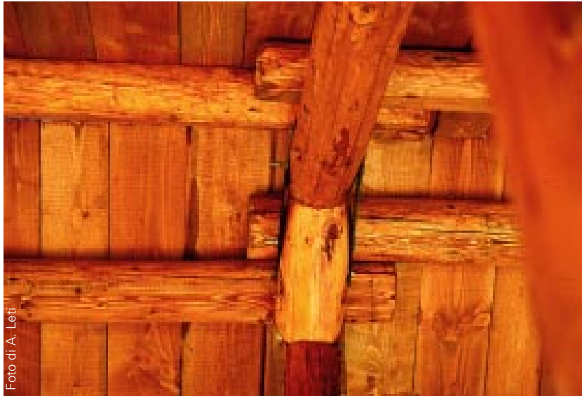
10. Tavolato di copertura e orditura primaria in legno di douglasia
